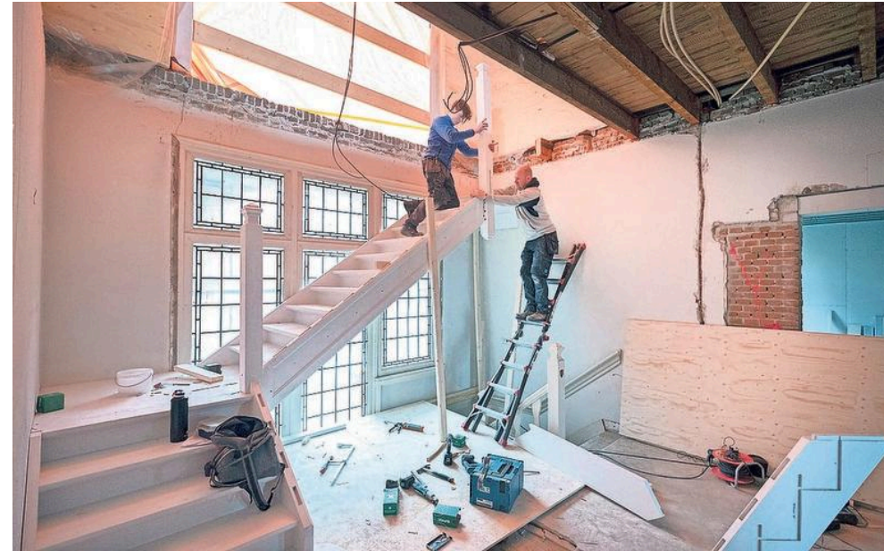
De verbouwing van de pastorie tot 'herstelhotel'.
