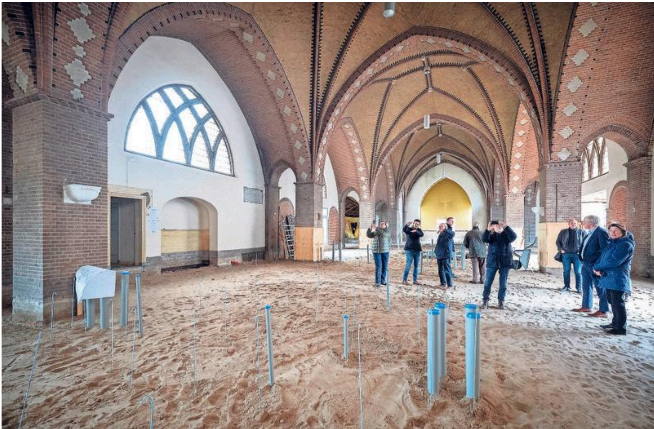
Rondleiding in de volledig gestripte kerk. Onder de grond is alles klaar.
